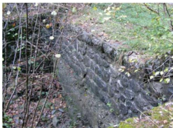
Opere di regimazione idraulica trasversali (briglie in pietrame e cls) lungo il torrente
