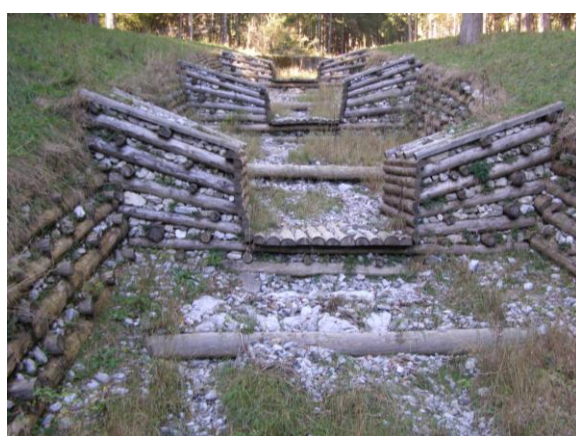
Opere di regimazione idraulica trasversali (briglie in legname e pietrame) lungo il torrente
