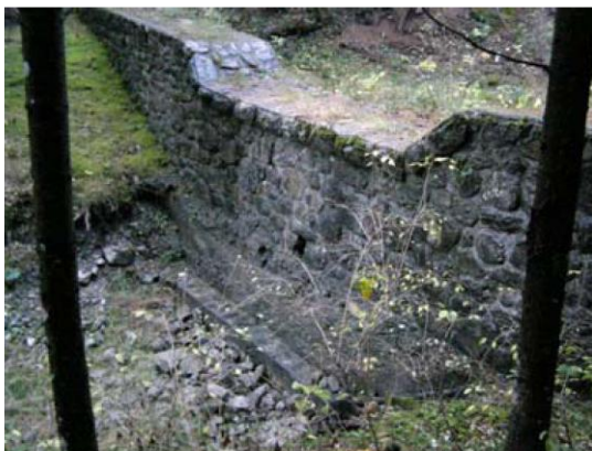
Opere di regimazione idraulica trasversali (briglie in pietrame e cls) lungo il torrente
