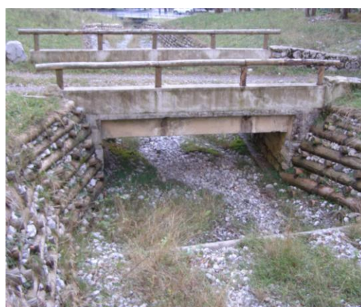
Opere di regimazione idraulica trasversali (briglie in legname e pietrame) lungo il torrente
